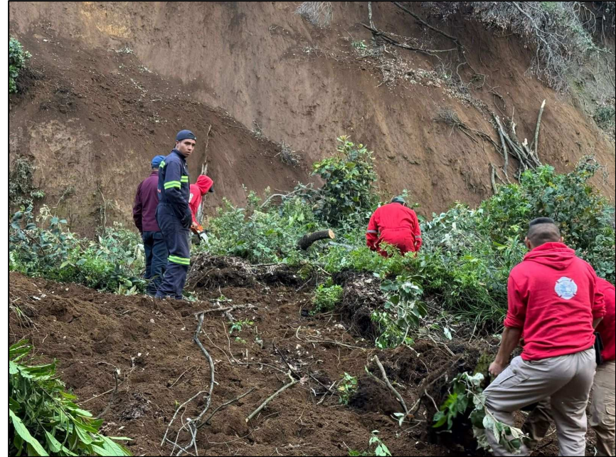
Figura 19. Atención a nuevos eventos de inestabilidad de laderas. En el tramo carretero San Luis Ayucan – Santa María Mazatla, donde se presentaron deslizamientos, se efectuaron trabajos de limpieza y retiro de escombros, así como derribo controlado de árboles en riesgo de caída, con la finalidad de garantizar la seguridad vial. Fuente: Fotografías propias.
