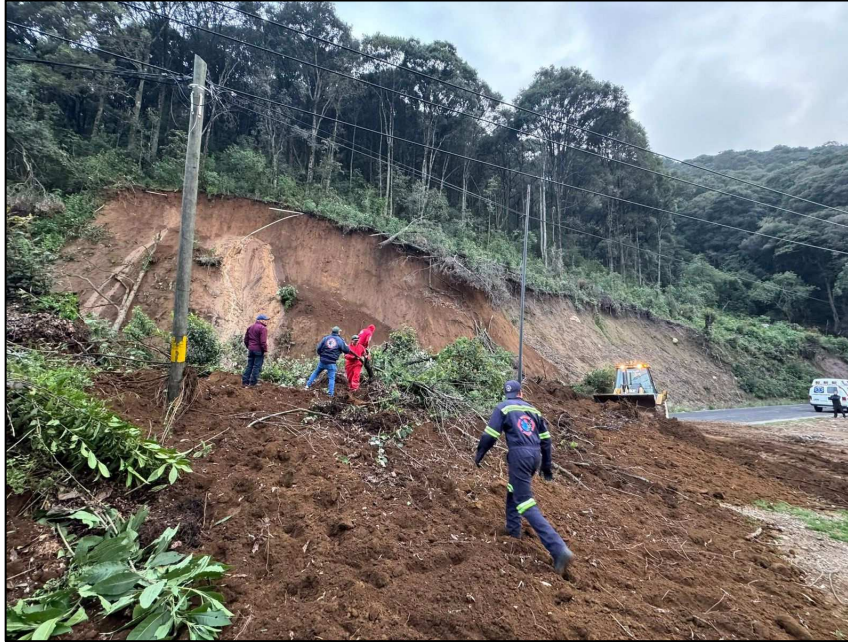
Figura 19. Atención a nuevos eventos de inestabilidad de laderas. En el tramo carretero San Luis Ayucan – Santa María Mazatla, donde se presentaron deslizamientos, se efectuaron trabajos de limpieza y retiro de escombros, así como derribo controlado de árboles en riesgo de caída, con la finalidad de garantizar la seguridad vial. Fuente: Fotografías propias.
