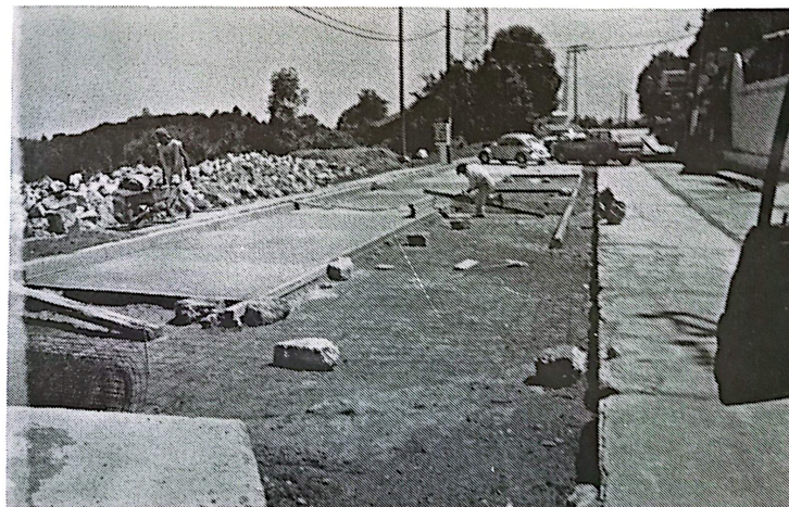
Rehabilitación y construcción de la avenida principal del pueblo de Espíritu Santo con concreto hidráulico.
