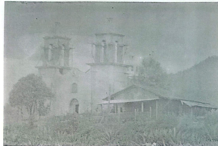
Fase terminal de la construcción de las dos torres de la iglesia de Espíritu Santo del año 1975.
