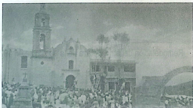
Vista de la construcción de la casa cural de 1964.
