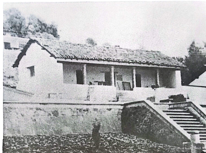
Segundo Edificio de la Escuela Primaria de Santa Ana.
