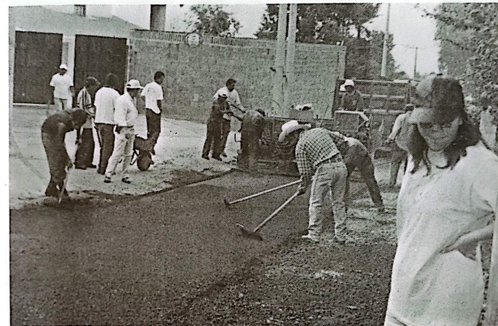
En el trienio se pavimentaron varias vialidades así como los trabajos de bacheo.
