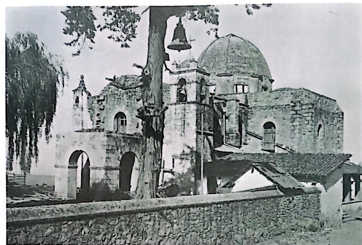
Construcción terminal de la parroquia de Santa María Mazatla, sin su torre principal.
